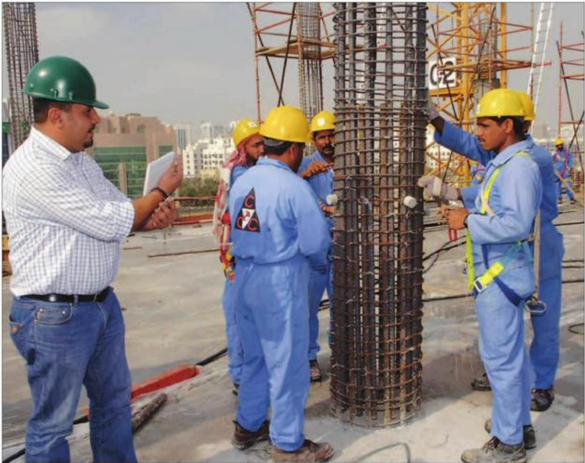
ارتفاع أسعار الحديد والأسمنت ترفع كلف البناء بنسبة تصل إلى نحو 30٪ (أرشيفية)
